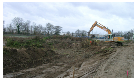
Deicherhöhung Bereich Hafen Süd
