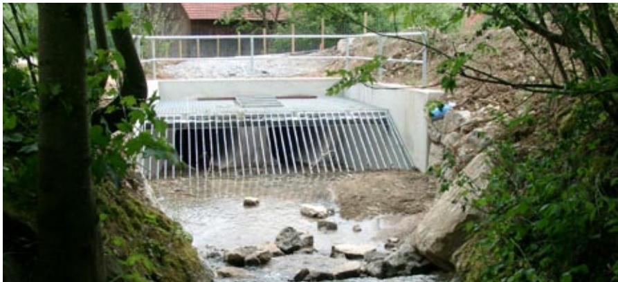
Einlaufbauwerk nach Fertigstellung
