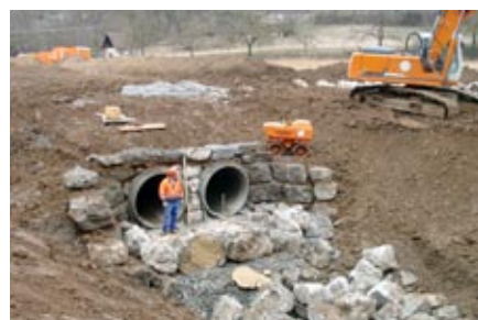
Tosbecken im Bau
