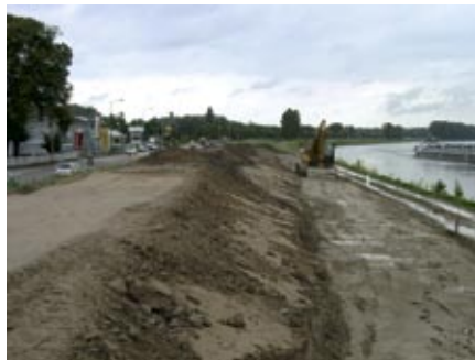
Wasserseitiger Ausbau während dem Bau
