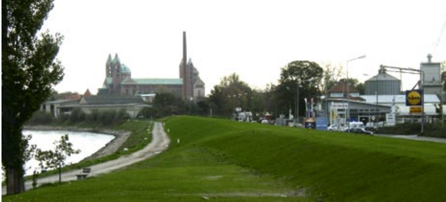
Deichabschnitt mit wasserseitigem Dichtteppich
