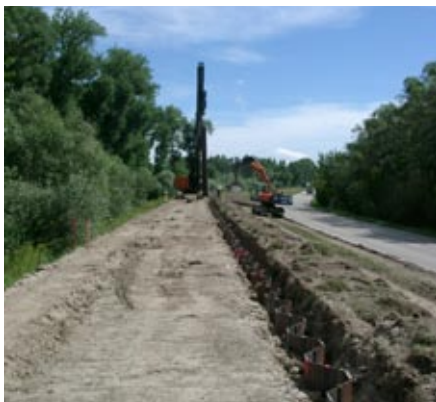
Deichtrasse mit Spundwand
