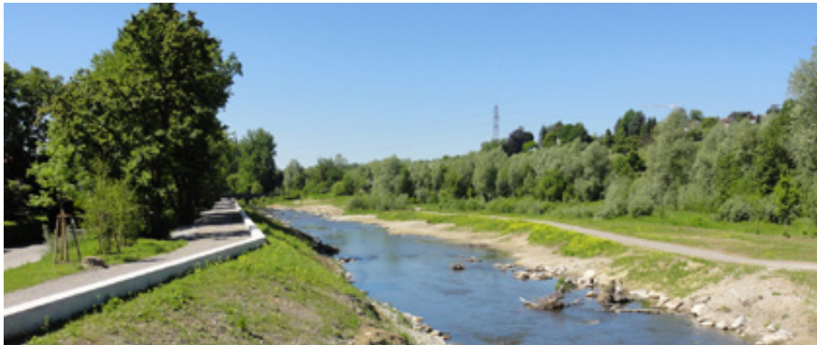
Spundwand mit Kopfbalken
