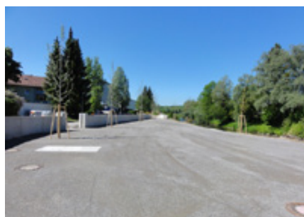
Neu angelegter Platz an der Winkelstützwand
