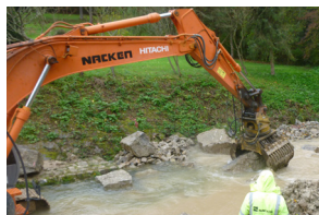
Versetzen der Riegelsteine
