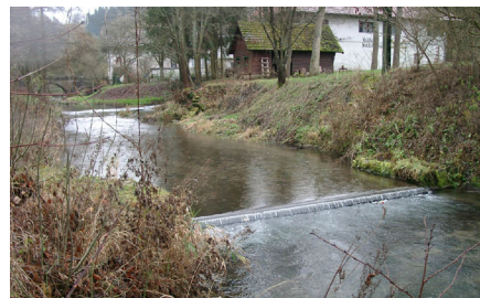
Pegelschwelle vor dem Umbau
