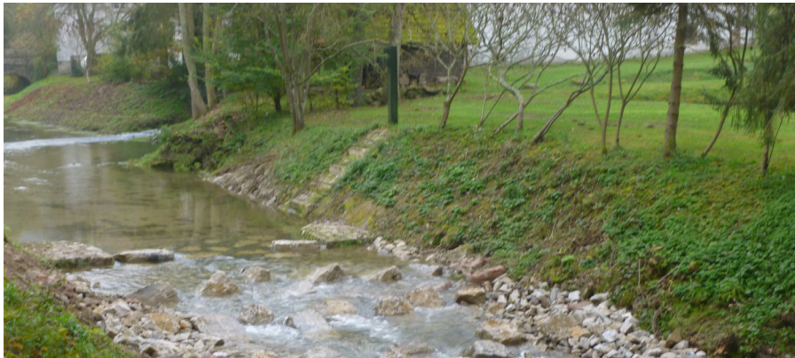
Aufgelöste Riegelrampe nach Fertigstellung
