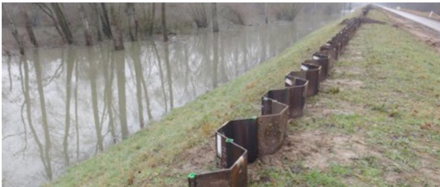
Spundwandeinbau im Bereich einer vorgesehenen Überlaufschwelle
