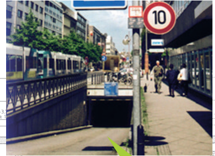
Unterirdische Zufahrtsrampe NI, Mannheim
