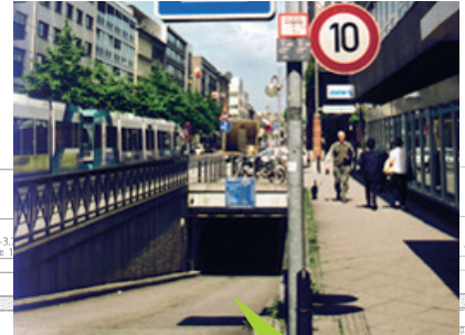
Unterirdische Zufahrtsrampe NI, Mannheim
