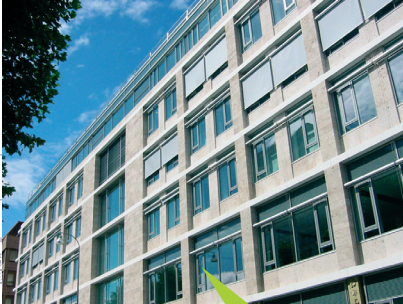
VR Bank Rhein-Neckar, Augustaanlage Mannheim
