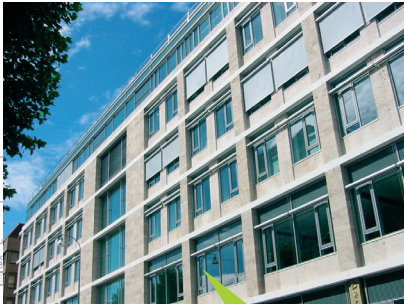
VR Bank Rhein-Neckar, Augustaanlage Mannheim
